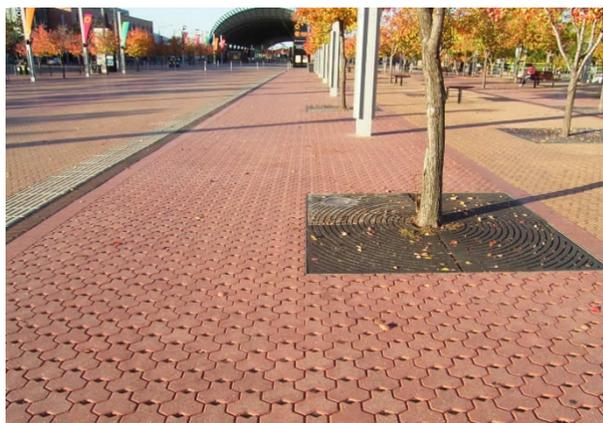
**Figura 4. Pavimentazione permeabile**
