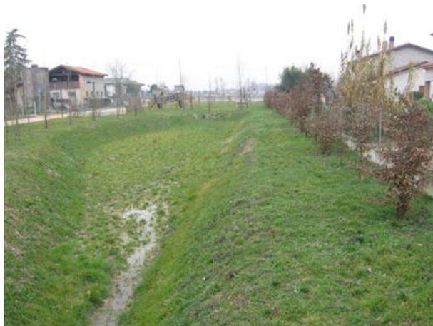
**Figura 2. Bacini infiltrazione**
